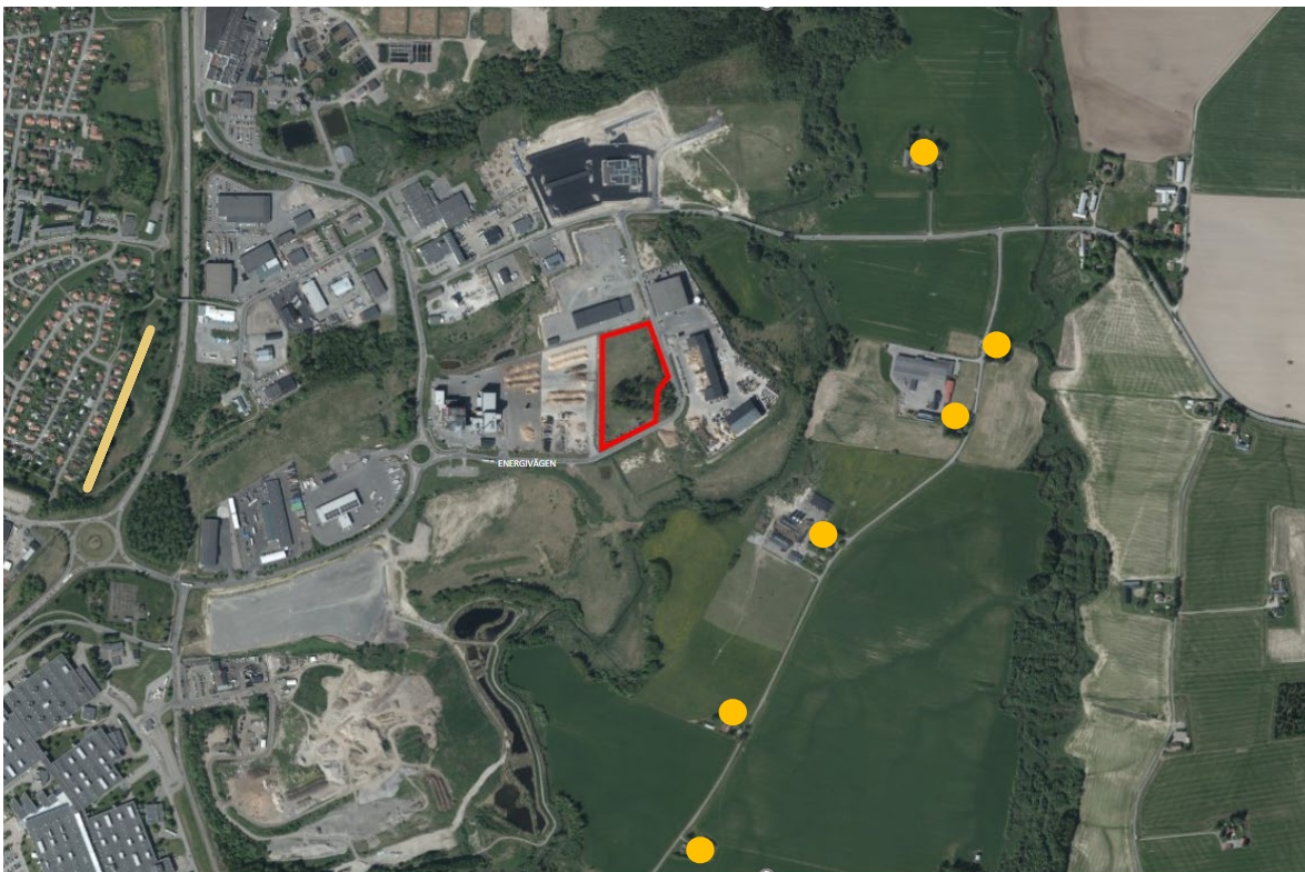
Figur 2. Översiktbild, Google. Röd markering avser fastigheten Värmekällan 4, gul markering närliggande bostäder.
